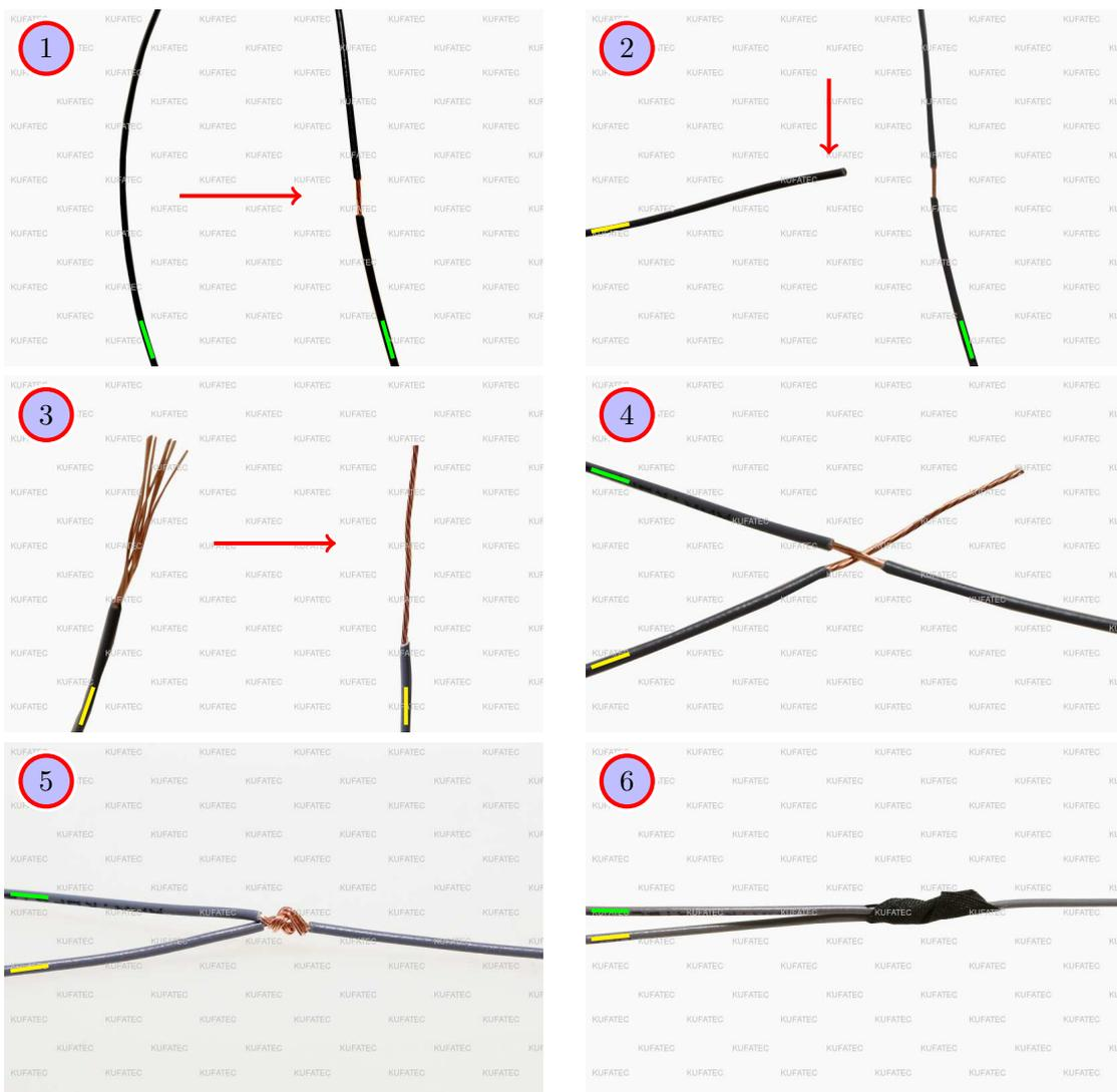
Abbildung 1: ein Kabel an ein anderes anschließen
